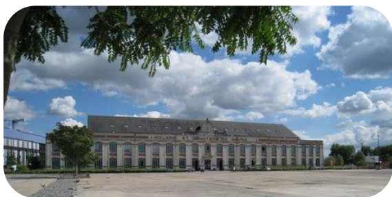
Parc des chantiers, Bâtiment Ateliers et Chantiers de Nantes ©MHT
