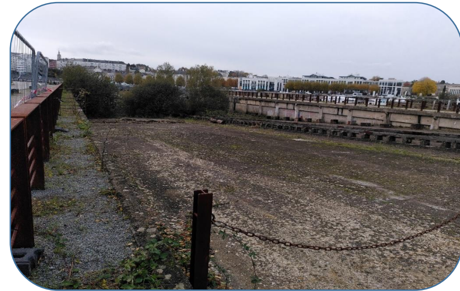
Cales de lancement, recouvertes par la végétation. ©MHT
